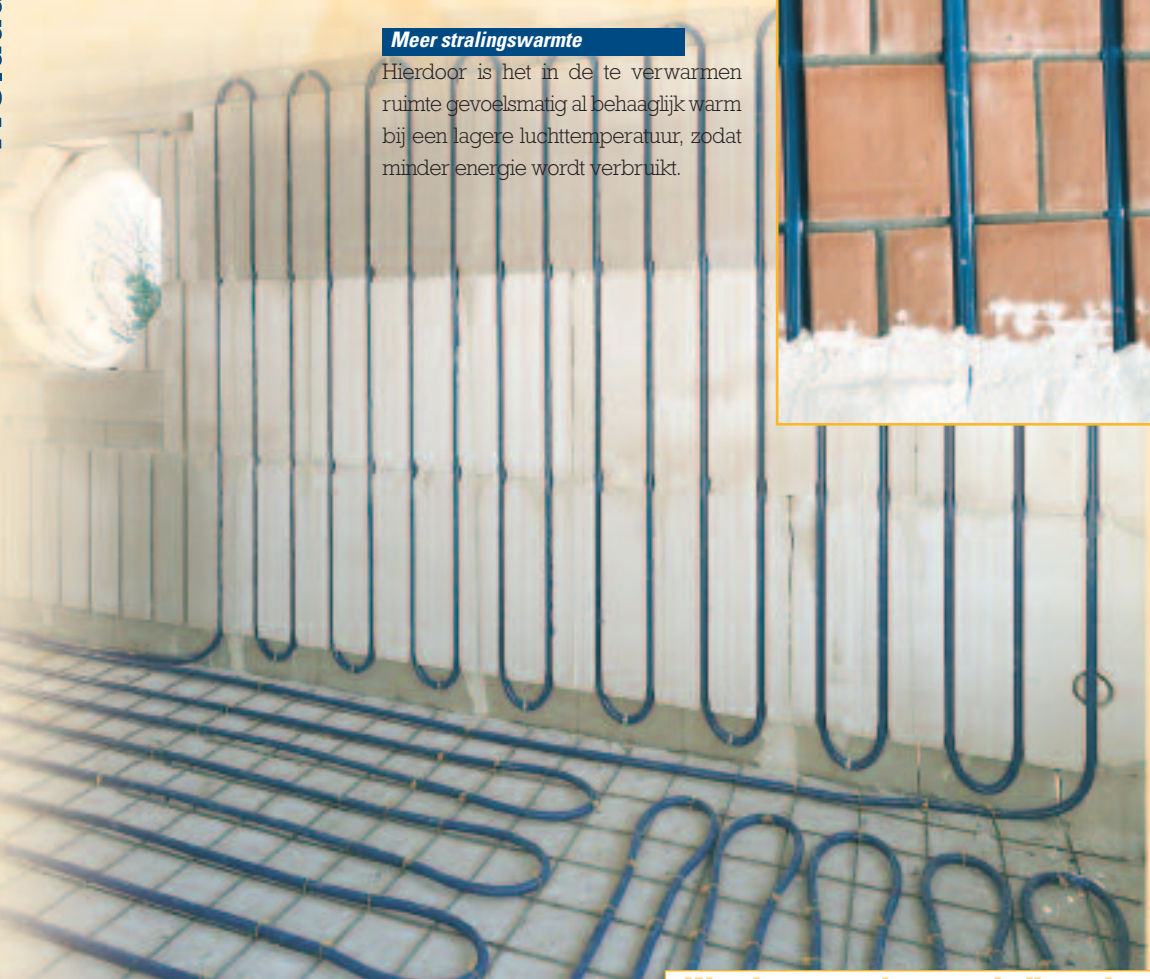
Wandverwarming met kalkzandsteen
