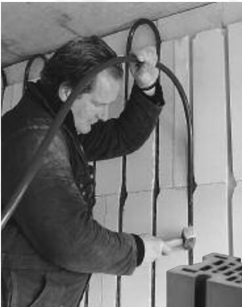
Wandverwarming met kalkzandsteen
